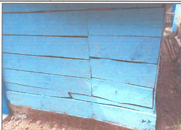
Foto1: Mejoramiento del aula de preprimaria
