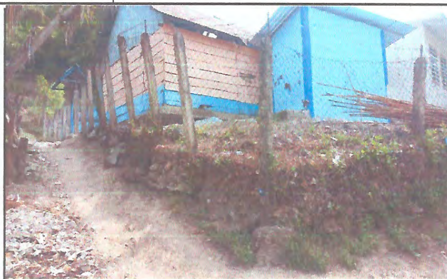
Foto 2: Mejoramiento de circulación perimetral
