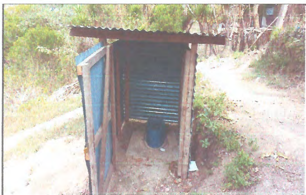
Foto 3: Mejoramiento de servicios sanitarios y sus accesorios.
